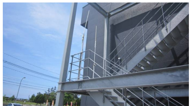
アンテナ設置状況
